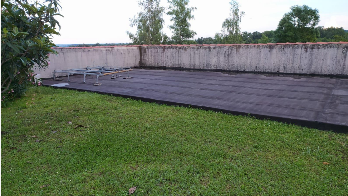
Vista da nord (copertura)
